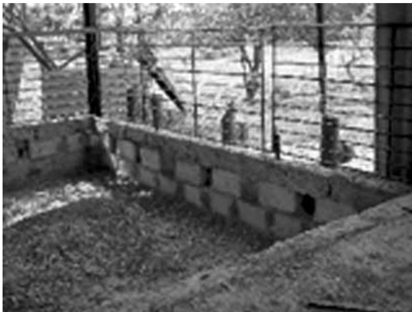
Figura 2. Muro contentivo y respiraderos del sistema de cama profunda en el Instituto de Investigaciones Porcinas de Cuba.
